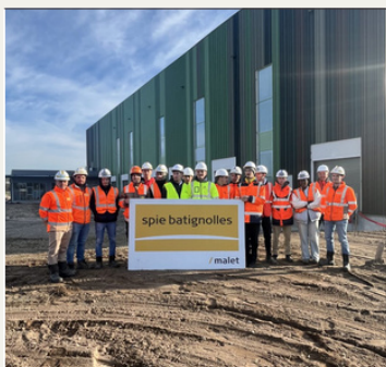
VISITE DE CHANTIER SPIE BATIGNOLLES
