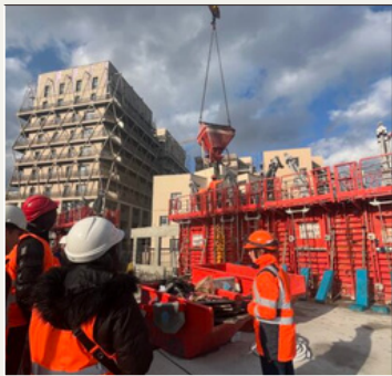
VISITE DE CHANTIER BOUYGUES CONSTRUCTION
